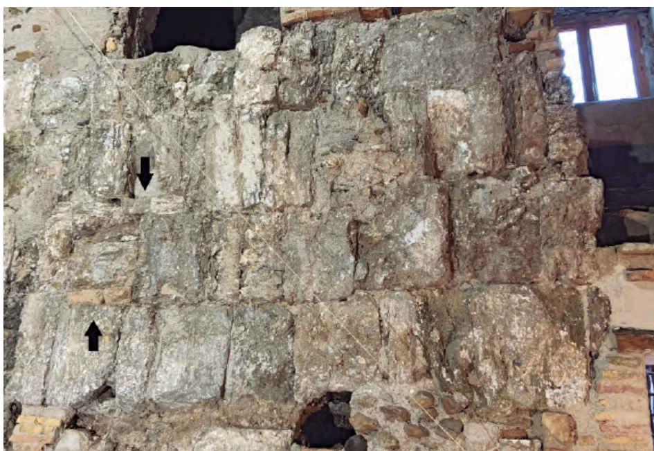
Fig. 11. Sillería islámica. Se han señalado algunos ejemplos de recalce. Fotografía: autor (Archivo Arqueología Municipal Zaragoza).
