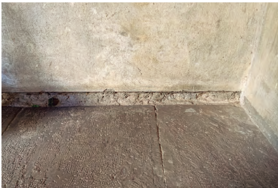
Fig. 12. Crujía oriental del claustro. Sillares visibles bajo el enlucido superficial de la pared. Fotografía: autor (Archivo Arqueología Municipal Zaragoza).
