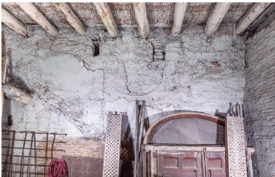
Fig. 2. Aspecto de las estructuras medievales (muro del refectorio) antes de la intervención. Fotografía: autor (Archivo Arqueología Municipal Zaragoza).
