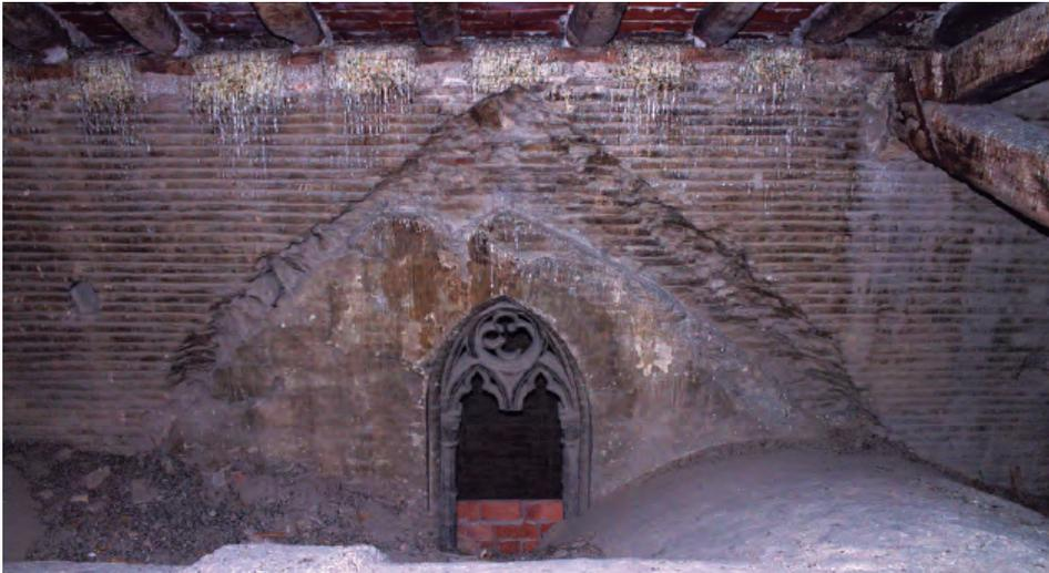
*Fig. 2. Iglesia de San Nicolás. Espacio bajo cubierta. Sobre la bóveda de cañón se observan las rozas en los muros correspondientes a los empotramientos de las bóvedas de crucería y el ventanal del crucero del lado de la epístola del templo gótico. Fotografía: autor.*
