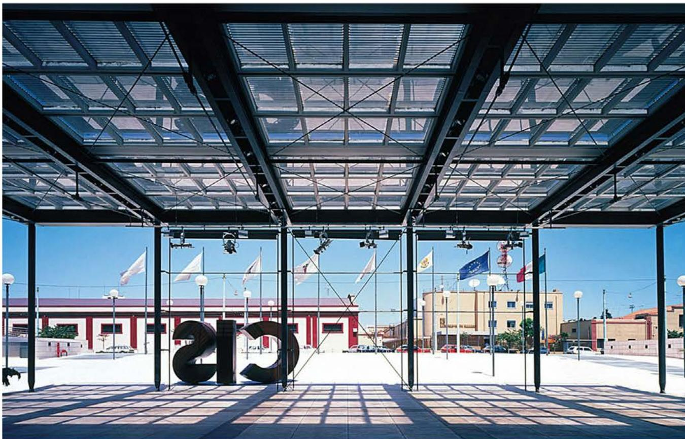
sezione quadrata 60x60 cm. I lati della maglia, 6,00x4,80 m, sono misurati all'interasse dei pilastri e sono composti dalle dimensioni nette: 0,30+5,40+0,30 lungo l'asse nord-sud e 0,30+4,20+0,30 nella direzione dell'asse est-ovest. In corrispondenza della direzione longitudinale della stecca si trova l'unica variante della maglia strutturale di base con l'introduzione di un interasse, lungo l'asse nord-sud, da 3,00 m avente dimensioni nette 0,30+2,40+0,30 [13-14].
